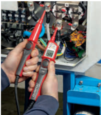
Prüfung der Ausgangsspannung einer DC-Ladeeinrichtung
